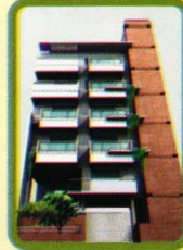
Geo Fakirhat Villa House : 5, Road No : 15 Sector No : 13, Uttara, Dhaka Size : 1500 sft
